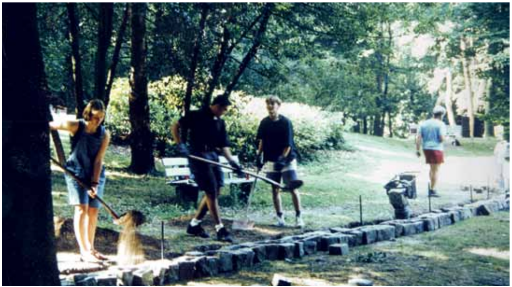
Jugendliche bei Wegebauarbeiten 1992
